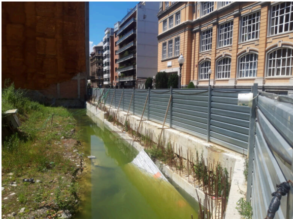
Las aguas estancadas en mayo.
