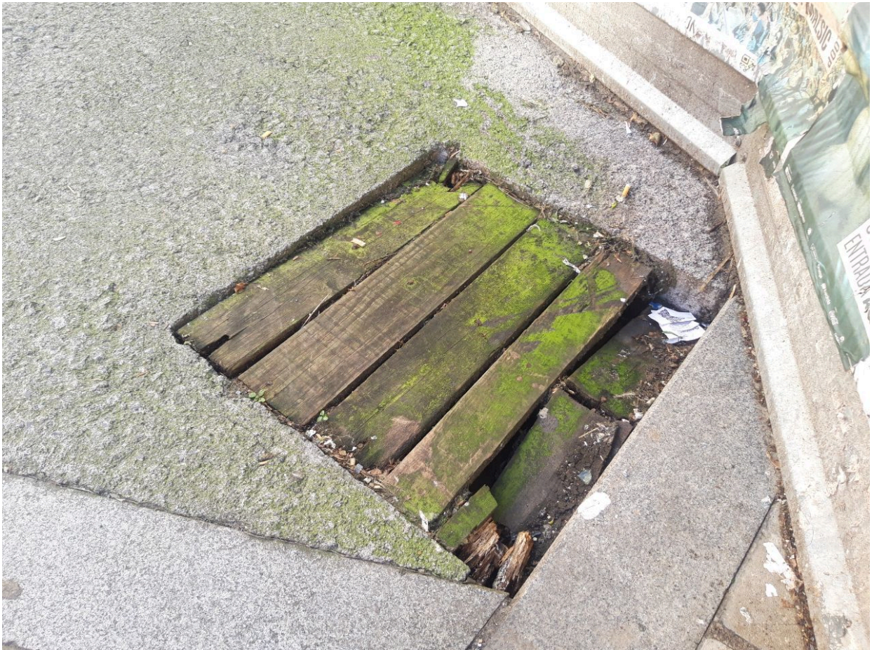
Tapa de madera sobre rejilla: rota y en deficiente estado de conservación.
