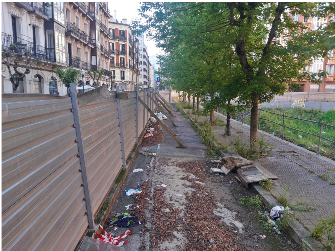
Zona de valla inestable: sin arriostramiento tras retirada de caseta de obra.
