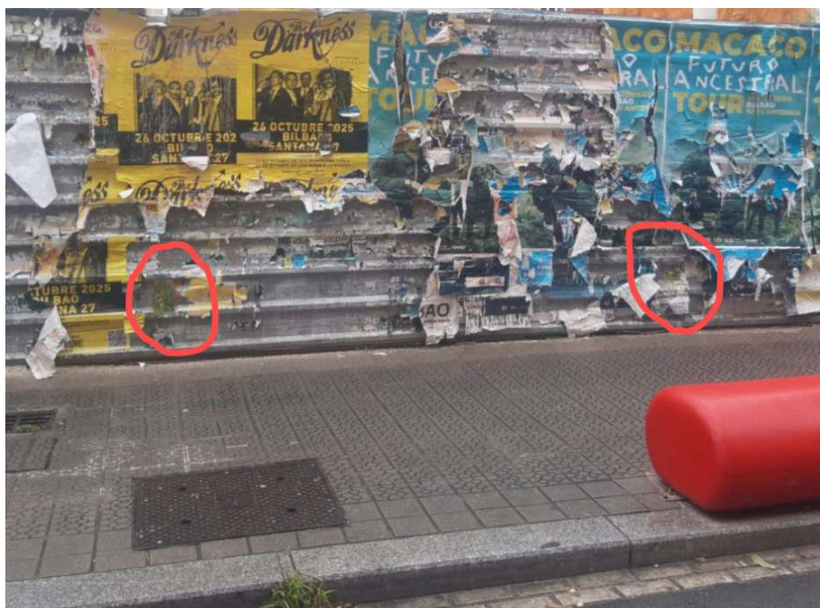
Figura 3: Se marca la ubicación de dos de los agujeros con bordes cortantes en la valla.
