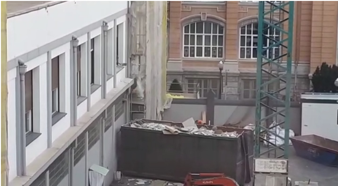
Fig. 1: Escombros tirados por la ventana y polvareda. Vídeo disponible en https://www.youtube.com/watch?v=3ptp07YSXx0 descargable en https://abandohabitable.org/wp-content/uploads/2021/06/210616_escombros-por-la-ventana_3.mp4 y adjunto a esta escrito.
