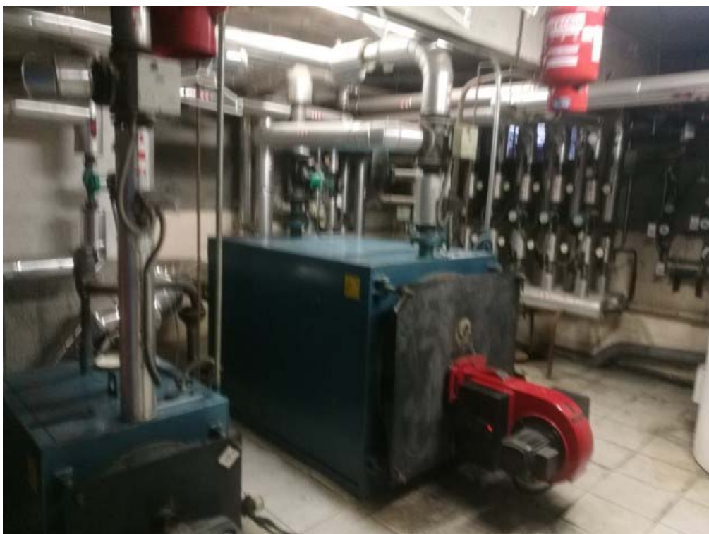
Sala de calderas en sótano
