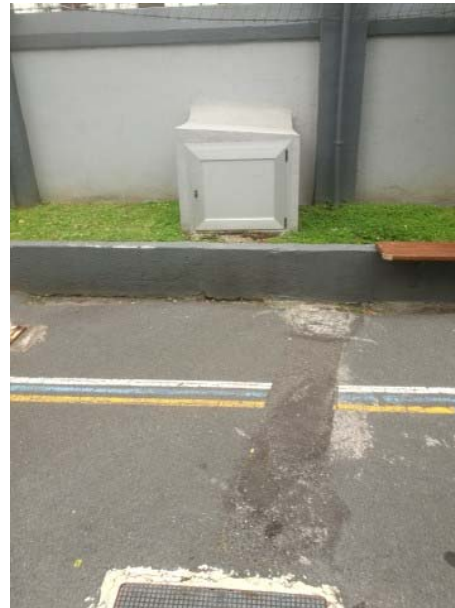
Boca de carga depósito de gasoil
