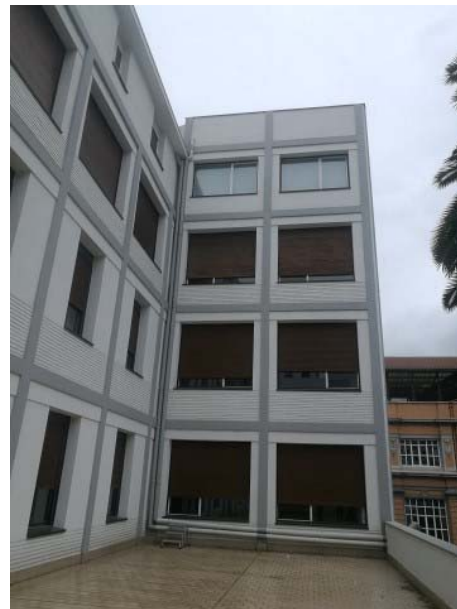
Fachadas sobre terraza del 1er piso
